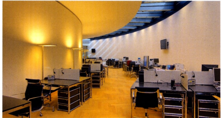
Bild 5 Einbauleuchten an den Dachstreben und Stehleuchten sorgen für ergonomisches und gleichzeitig energieeffizientes Arbeitslicht. (Fotos: BBL/Alexander Gempeler)
