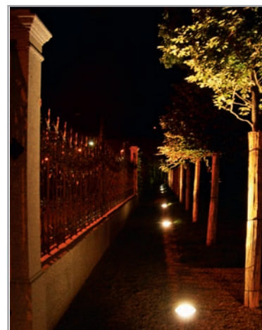
Bild 4 Der Eindringerschutz ist bei Bodeneinbauleuchten von allen Seiten – auch von unten – sorgfältig zu planen.
