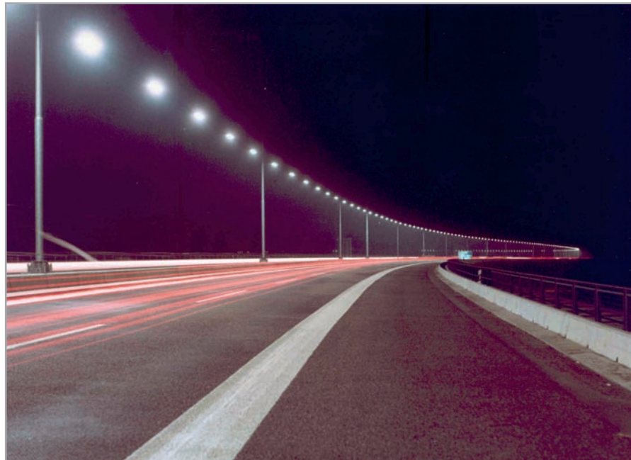
Bild 1 Die klar strukturierte Anordnung der Strassenkandelaber unterstützt die visuelle Führung der Verkehrsteilnehmer.
