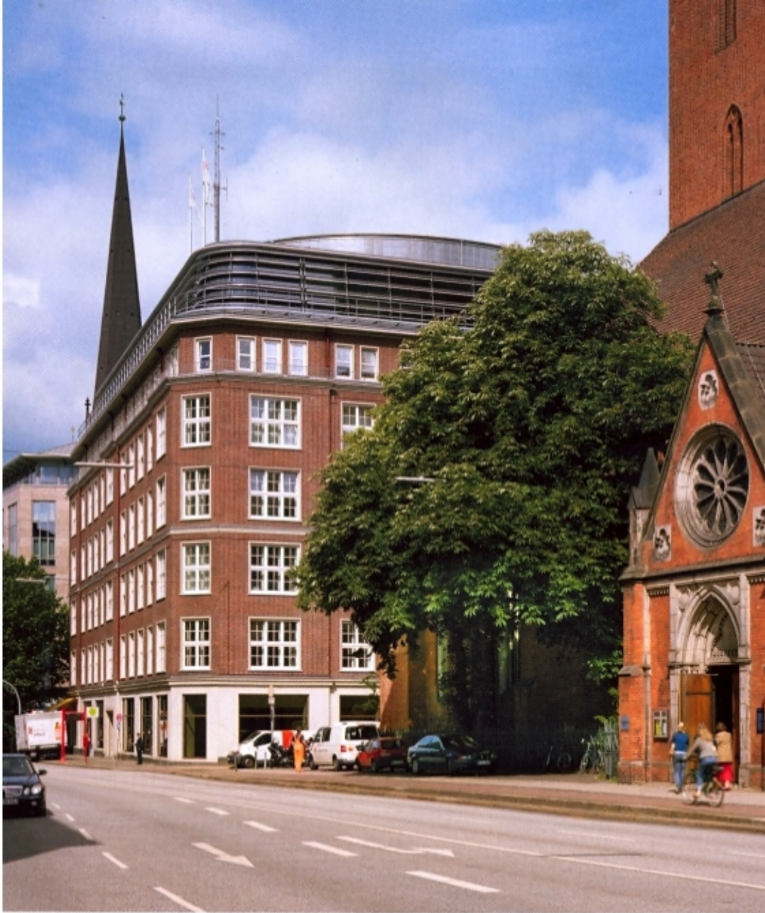
1 Der Aufbau der Aufstockung greift außen die horizontale Gliederung des Hochbahn-Hauses auf und setzt sie mit Glas und Stahlelementen modern um. 2 Man hat die alte Fassade aufgenommen, ist dann aber staffelförmig zurückgesprungen – die Bewegung wurde nach innen gerichtet. Eine mutige, auskragende Bedachung wurde an dieser Stelle von Hamburgs Baubehörde nicht toleriert.
