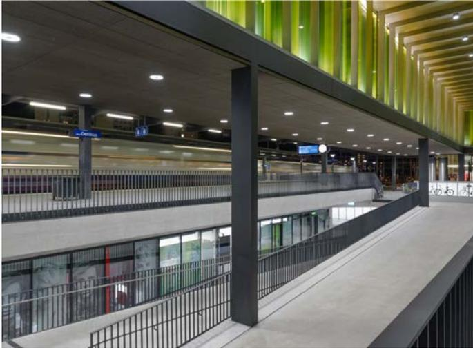
**Abb.:** Die Raumbelichtung innerhalb der »Laternen« erfolgt über Deckenaufbau-Tiefstrahler, während die grünen Glaselemente mit linearen Lichtquellen bespielt werden. Foto: Marc Uebersax, vogtpartner
